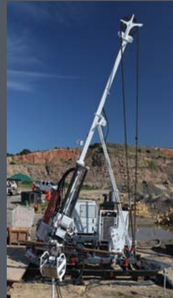
Equipos para extracción de testigos en superficie
